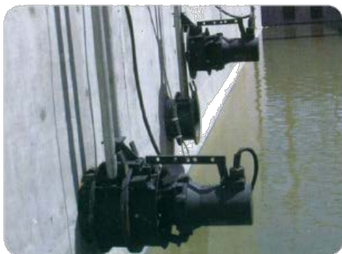
Рис № 07. Установка ПНВИ с подъемным устройством и проходной трубой
