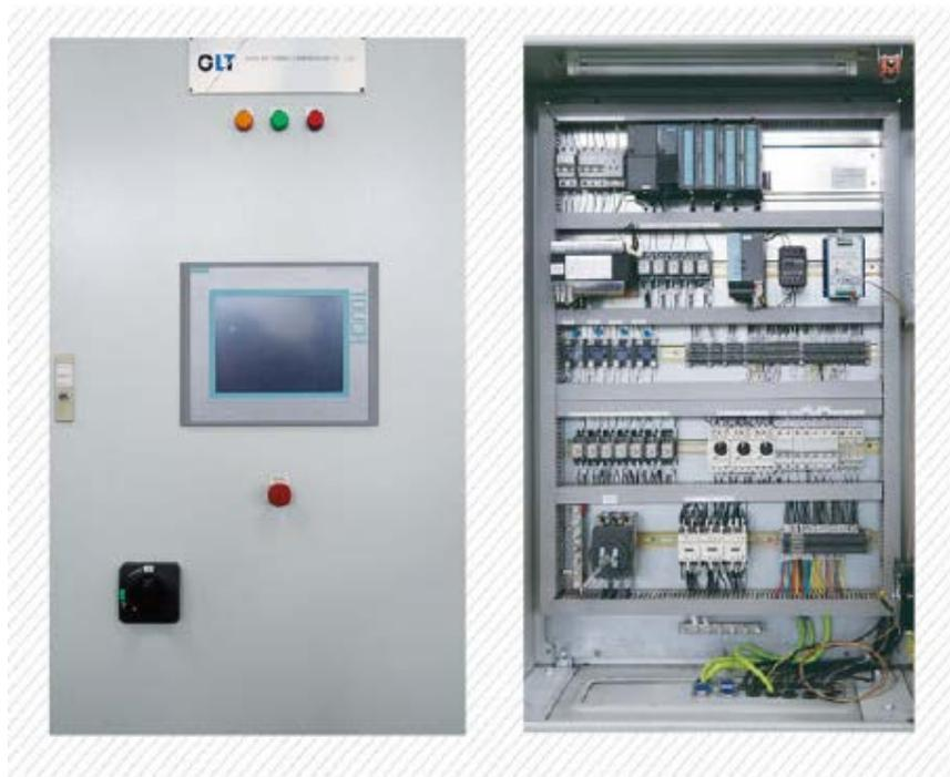
Рис № 18 Локальная панель управления турбокомпрессором
