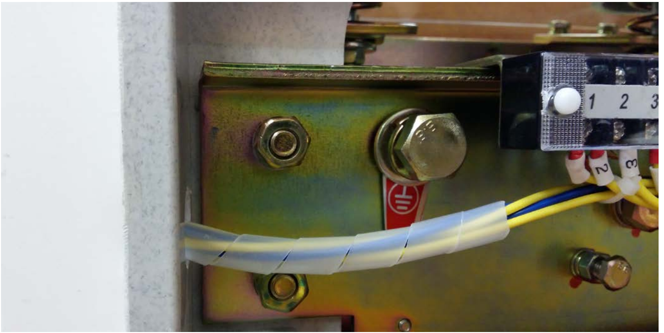
Рисунок 8 – Заземляющий болт контактора
